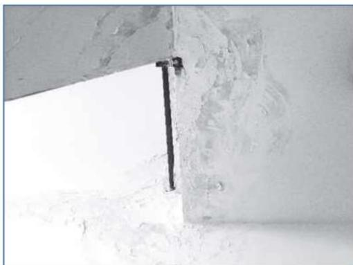
*Fotografia 13 – Infiltrazione torrino scala*
