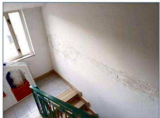
*Fotografia 14 – Infiltrazione corpo scala*
